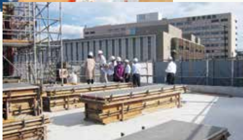
地鎮祭・建築中の風景 (2018)
